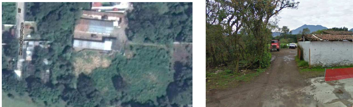
Figura 2. Fotografías de la ubicación del rancho para la instalación del biodigestor
