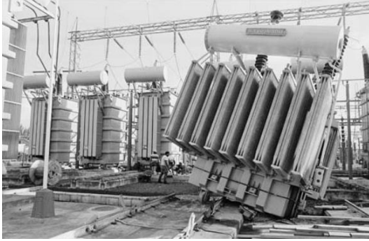
Figura 2 Subestación en Edgcumbe, Nueva Zelanda, 1987 [Fierro, 2010].
