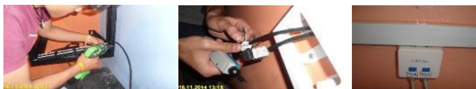
Figura 6. Tendido de cableado estructurado y etiquetado
