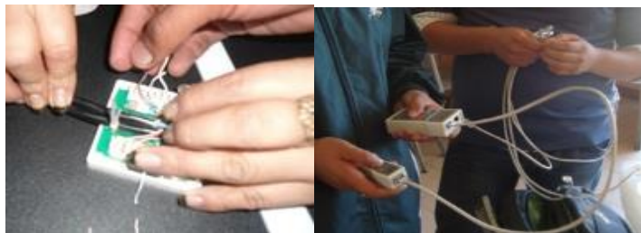
Figura 3. Configuración de Jack RJ45 y crimpado de cables de red.
