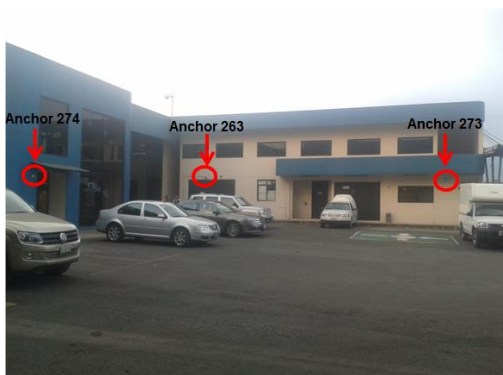
Figura 7. Sistema instalado en exterior.
