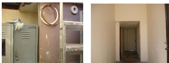
Figura 1. Entrada al departamento de mantenimiento antes y después de las 5s
