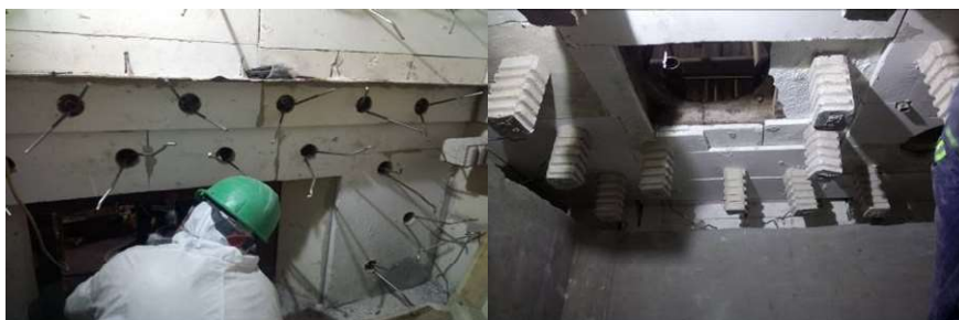
Figura 6. Instalación de sistema de anclaje mixto
