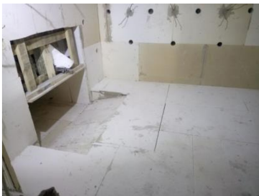
Figura 5. Instalación de tableta de fibra cerámica refractaria
